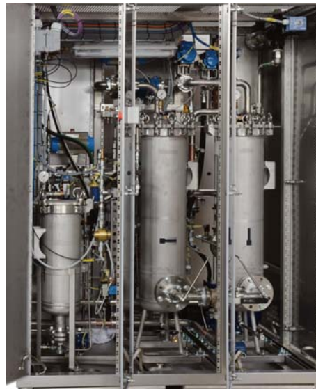
Filter in der Hydraulikversorgung
