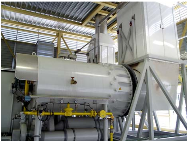
Propangas-Heizer 1300kW mit Wärmetauscher
